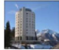
Hotel La Torre Saouze d'Oulx Italy
